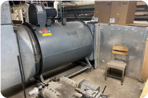
FIGURE 3.4 Return / Exhaust Fan
